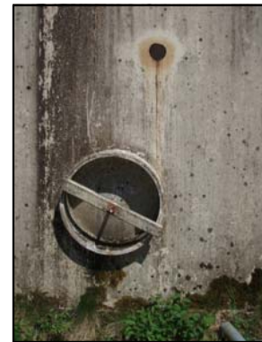
9 30" dia. side access manhole
