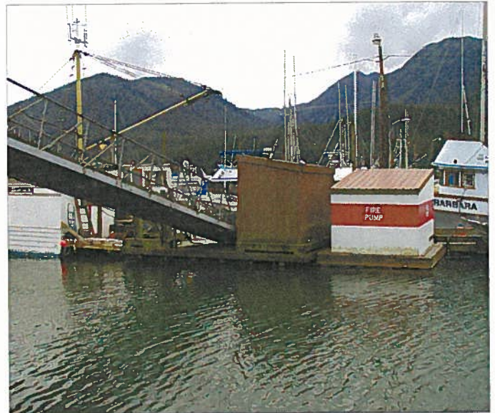
AURORA 016.jpg "C" GANGWAY LANDING FLOAT
