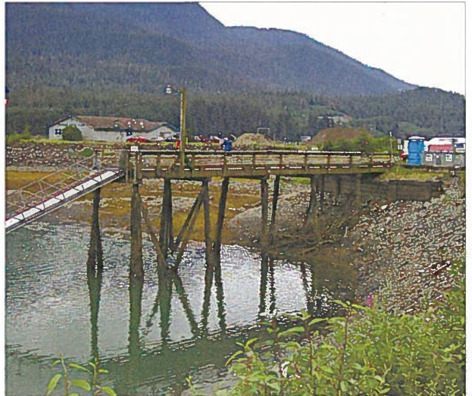
AURORA 054.jpg "N" GANGWAY APPROACH DOCK
