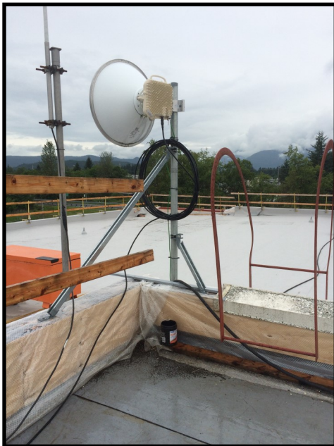
Microwave dish #2 Remove & Reinstall. Coord. W/Proj. Mgr.
